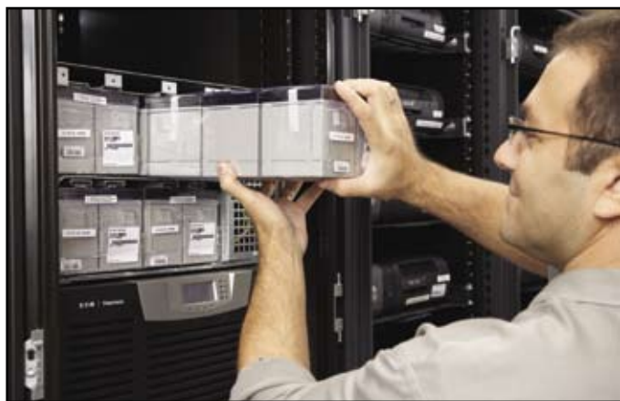
ИТ-персонал может легко производить замену аккумуляторных модулей.
