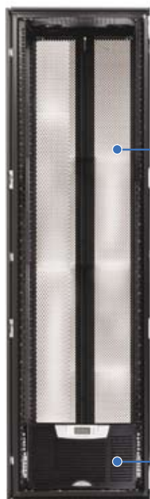
Первый год: Первоначальный монтаж
